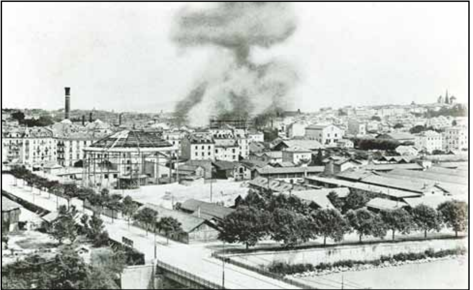
L'Explosion de l'usine à gaz le 23 août 1909
